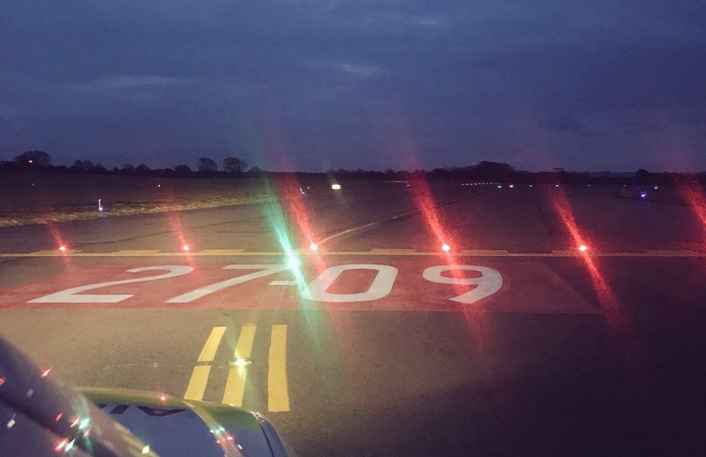
Lâmpada Unidirecional. Pouca visibilidade da pista quando voando fora de seu alinhamento.
